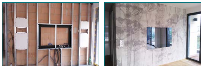
Obr.: Instalace neviditelných reproduktorů do sádkartonové stěny/stropu (finální povrch – tapeta).
