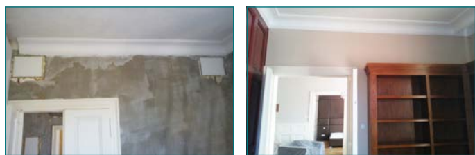
Obr.: Instalace neviditelných reproduktorů do cihlové stěny (finální povrch – štuk).
