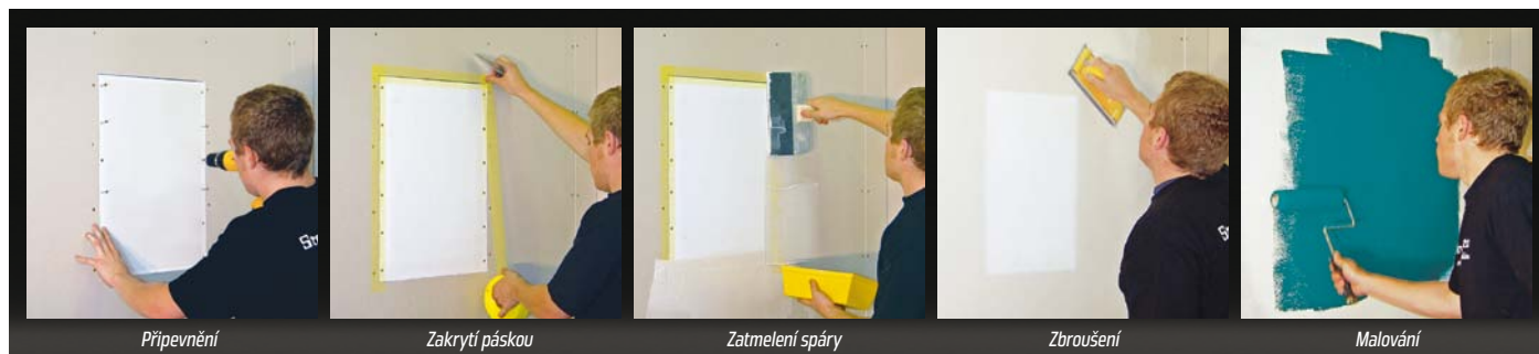
Obr.: Postup při instalaci do sádkartonové stěny
